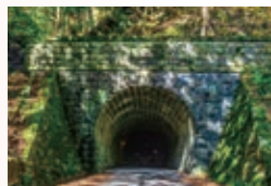
旧天城トンネル
